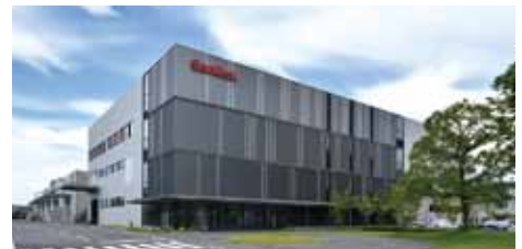
● 滋賀工場 (電源機器) Shiga Plant (Power supplies)
