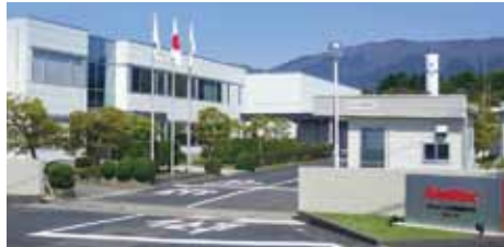
● 岡山工場 (半導体) Okayama Plant (Power semiconductors)
